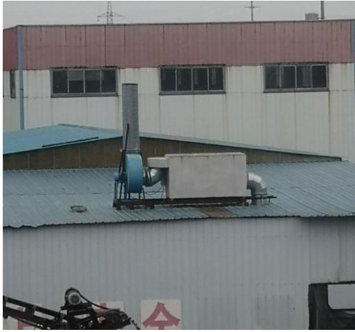
布袋除尘器及排气筒
