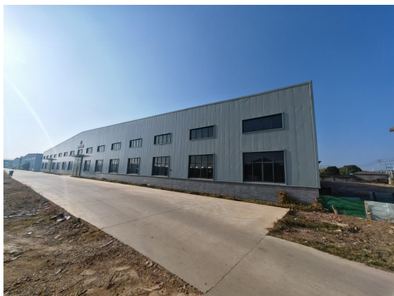
项目建设现状
