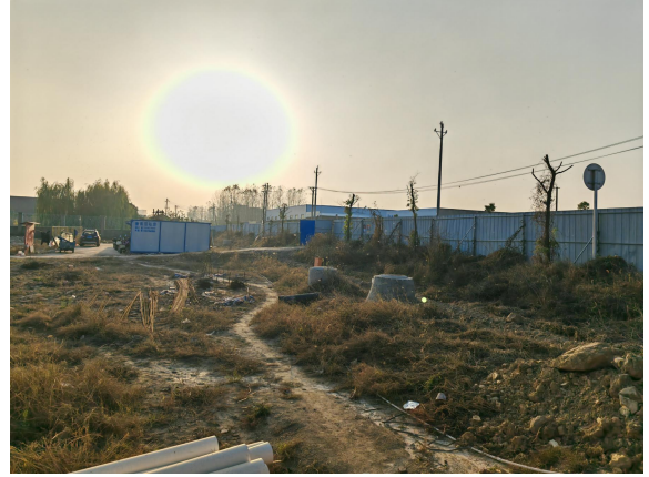
项目区雨水井
